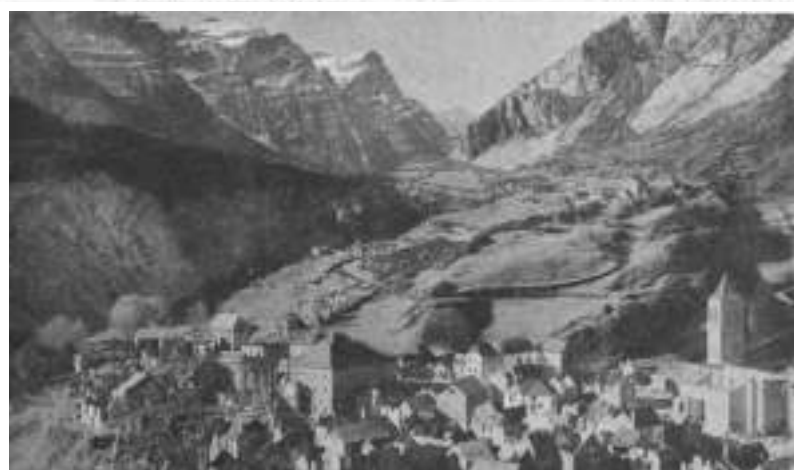
Fig. 14. — Bielsa, iniciadas las obras de reconstrucción. Encima del pueblo, se ve la pequeña aldea de Javierre. (Foto PASQUAL)
