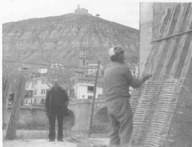
Ilustración 17. Cañizo s. m. estructura construida con cañas. José Revilla confeccionando cañizos . Detrás, en planos sucesivos: el puente sobre el Alcanadre, la iglesia parroquial de la Asunción y la ermita de San Juan. (Foto realizada por Amparo-Ángeles Soler Betés en 1992)
